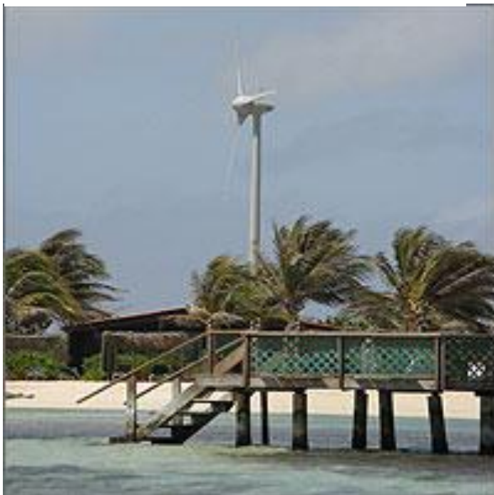
Uno dei 12 aerogeneratori
