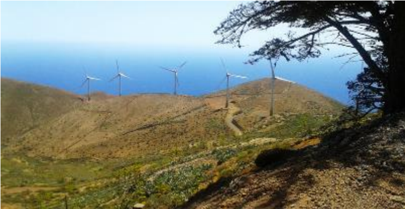
Aerogeneratori della centrale idroeolica
