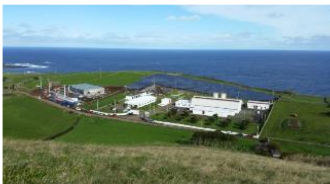
Panoramica impianto fotovoltaico
